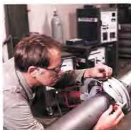
Zu den Kunden der Schweisstechnik AG zählt auch die Gebrüder Sulzer Aktiengesellschaft in der Schweiz. Mit Orbital-Technik werden unter anderem Rohre aus Titan geschweißt.
