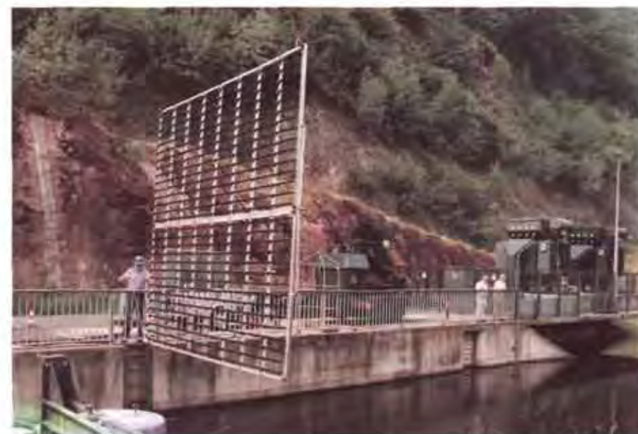
Bereits an drei verschiedenen Orten im Saarland haben wir Systeme für den automatisierten Ertrag von Sauerstoff zur Belebungs der Saar installiert. Die Gasevorsorgung erfolgt über unsere Fernleitung oder, wie an der Staustufe Mettlach, über eine Tankanlage.
