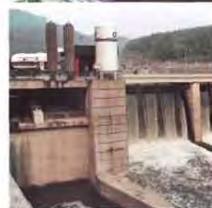
Bereits an drei verschiedenen Orten im Saarland haben wir Systeme für den automatisierten Ertrag von Sauerstoff zur Belebungs der Saar installiert. Die Gasevorsorgung erfolgt über unsere Fernleitung oder, wie an der Staustufe Mettlach, über eine Tankanlage.
