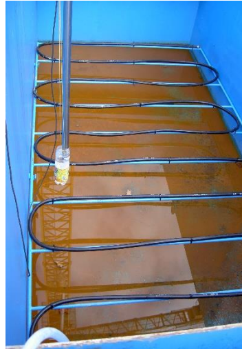
Neutralisationsbecken mit Begasungsschlauch
