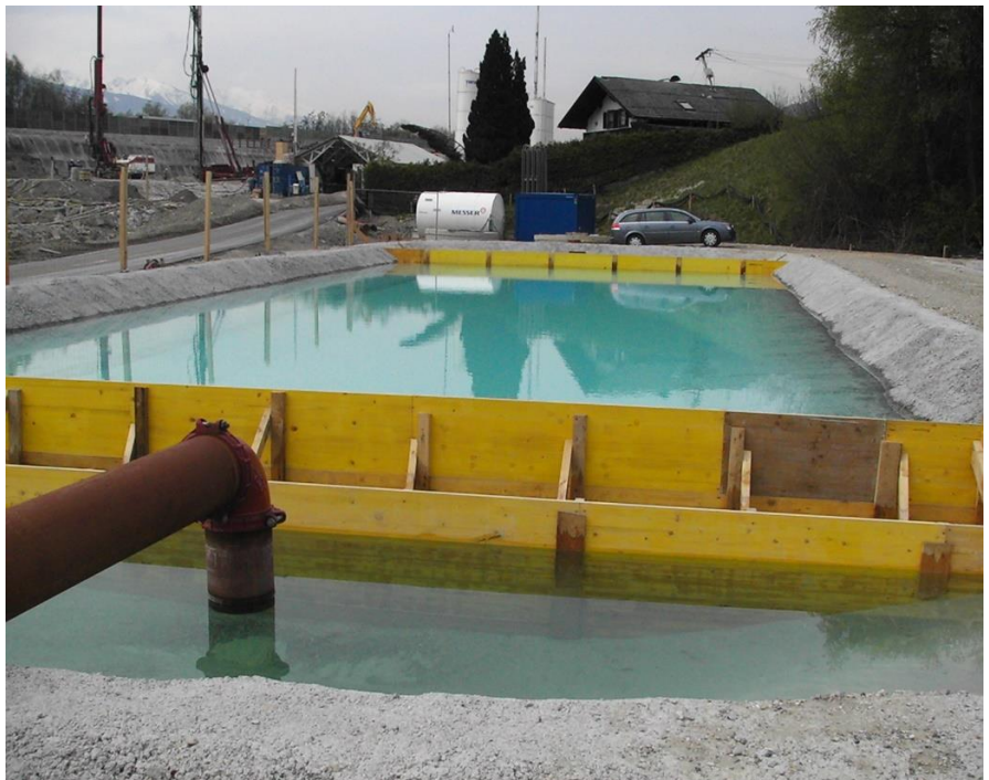
Neutralisation von Bauabwasser bei einer Grossbaustelle
