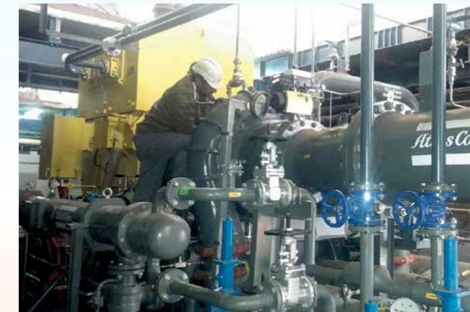
razlaganje vazduha, kao i kiseonički kompresor koji će direktno snabdevati visoke peći u Železari. Plan je da se montaže i puštanje u rad oba kompresora završi do kraja godine.
