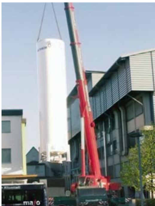
Installation des Stickstofftanks auf dem Gelände von Zeiss
