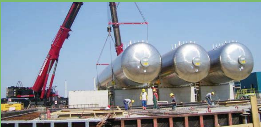
Installation der Lagertanks für das flüssige Kohlendioxid
