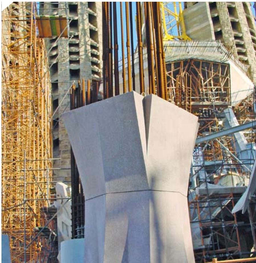
Escofet schweißt unter anderem die kunstvollen Beton-Stahlstrukturen der Sagrada Família.
